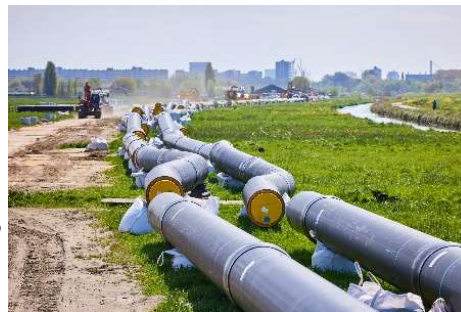
Warmteleidingen tussen Delft en Vlaardingen Bron: WarmtelinQ / fotografie Vincent Basler
